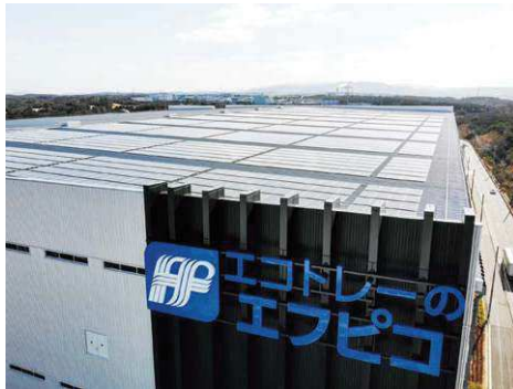
関西拠点の太陽光発電設備
