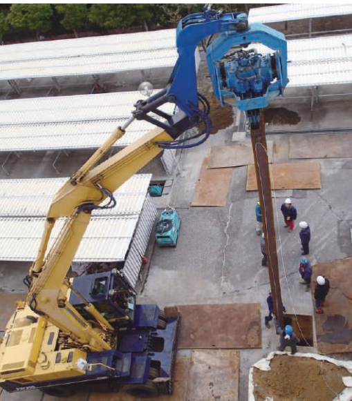
施工の様子 (重機とパイプハンマーを使ったACEライナーの打設)
