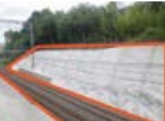
線路の法面補強
