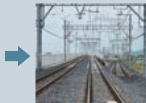
下り線高架切替え後
