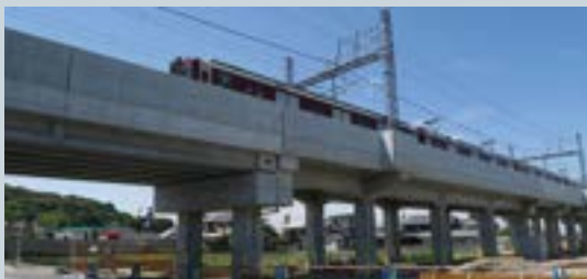
長野線 喜志駅～富田林駅間(踏切廃止箇所)
