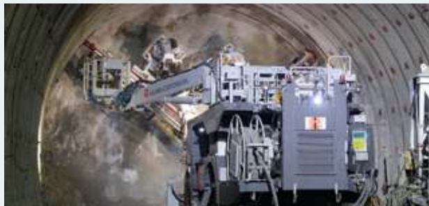
「A 4 CSEL for Tunnel」自動化されたロックボルト施工
