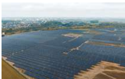
グエノベファ太陽光発電施設(ポーランド)
