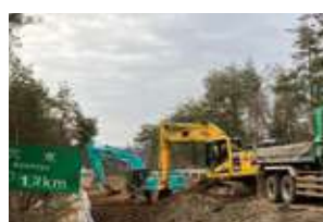
のと里山海道の復旧工事
