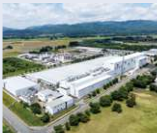
TDK北上工場新製造棟 (岩手県・2024年竣工)
