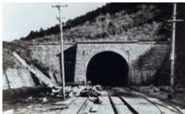
丹那トンネル(1934年完成/静岡県)
