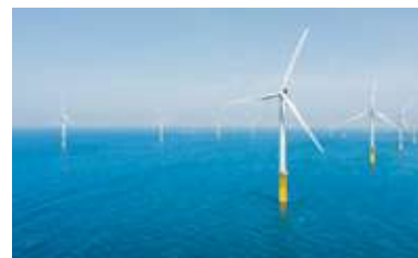
秋田港・能代港洋上風力発電施設建設工事 (2023年完成/秋田県)
