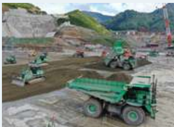
自動化施工技術 A4CSEL®(クワッドアクセセル)
