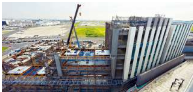
施工中のHICity (2022年7月撮影)
