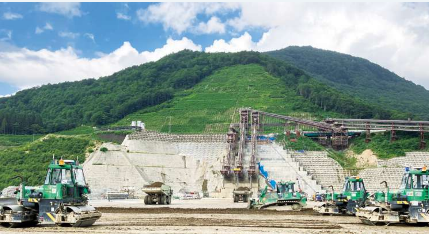
A 4 CSELを導入し、自動化建設機械で堤体打設作業を行う成瀬ダムの現場（2023年8月撮影）
