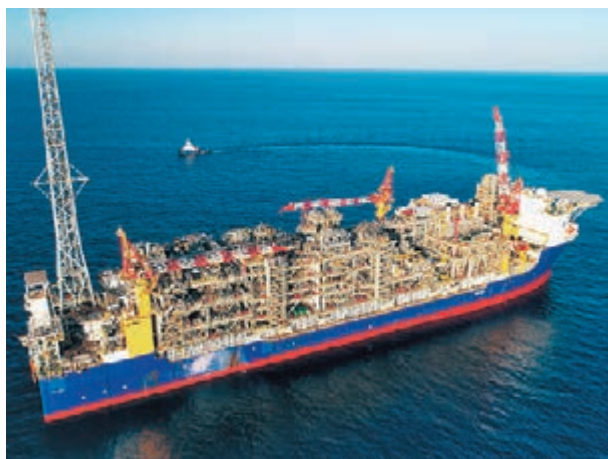
沖合生産・貯油出荷施設(FPSO)
