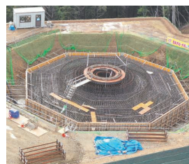
尾根基礎工事
