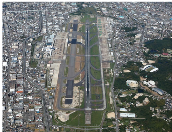
工 事 名：令和5年度福岡空港滑走路増設滑走路新設外工事（第4次） 発 注 者：九州地方整備局 博多港湾・空港整備事務所 工事場所：福岡県福岡市 工 期：2023年9月10日～2025年3月31日 写 真 提 供：九州地方整備局 博多港湾・空港整備事務所
