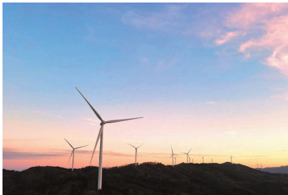
■ かわうち鬼太郎山風力発電所（福島県）
