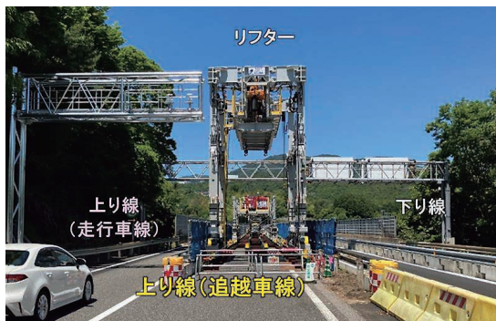
幅員方向分割でSDRシステムを適用した伴高架橋
