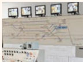
駅構内の信号機と転つ機を関連づけて列車を安全に運行させるための装置
