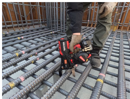
“TWINTIER” Rebar tying tool
