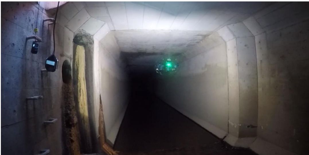
栃木県野木町での ELIOS 3 を活用した下水道管路内点検の様子
