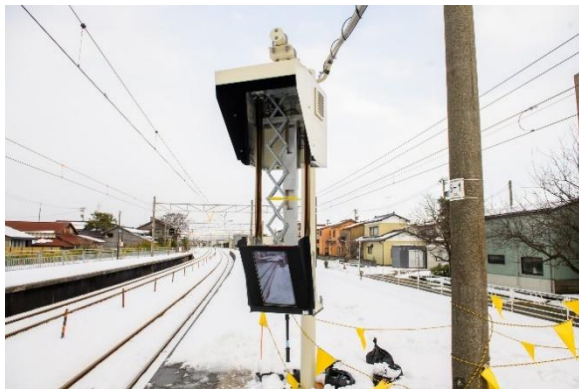
屋根なしエリアの 24 型液晶ワイドカラーモニター実装昇降式モニターハウジング
