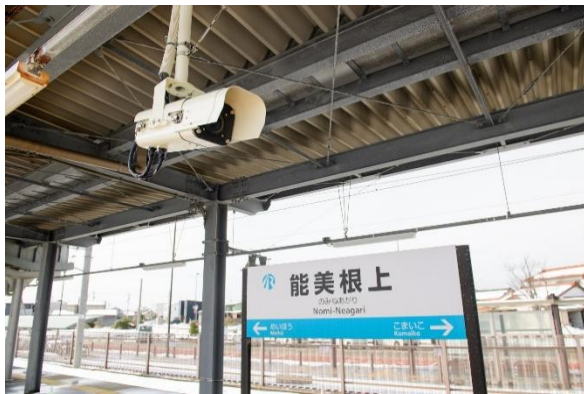
カメラハウジングに実装した監視用高感度フル HD カラーカメラ
