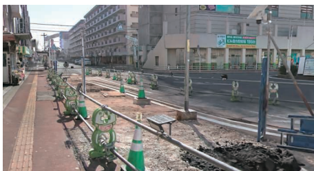
土木・建設などの工事現場での活用
