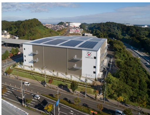
物流施設の施工例
