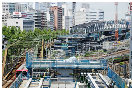
JR線10線をまたぐ京急本線品川・北品川間 八ツ山橋りょう架替
