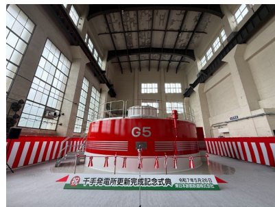
JR東日本信濃川発電所（千住発電所） の設備更新工事
