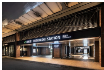
首都圏の中核駅の一つである 新橋駅の改良
