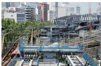
JR線・新幹線の10線を跨ぐ 八ツ山橋りょう架替
