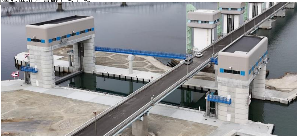
淀川大堰閘門 全景
