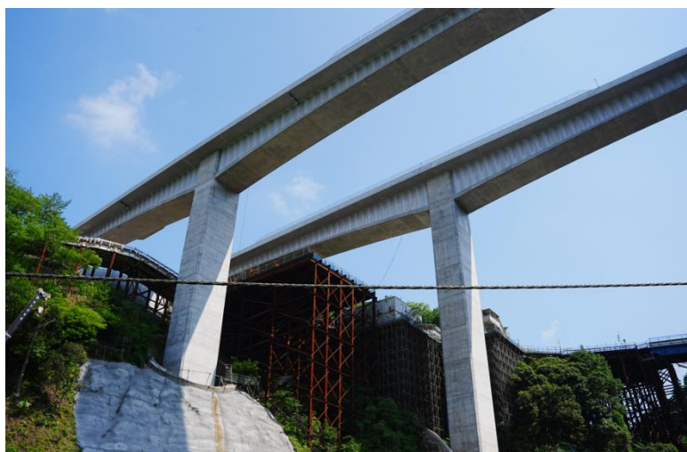
新東名高速道路「新皆瀬川橋」
