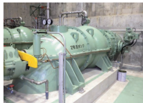
◀雨水排水ポンプ (横軸斜流ポンプ PSH型)
