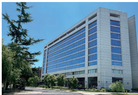
チリ現地法人オフィス外観写真
