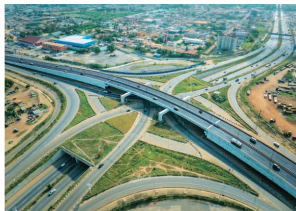
ガーナ共和国 テマ高架橋
