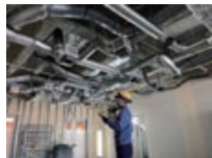
空調ダクト設備工事
