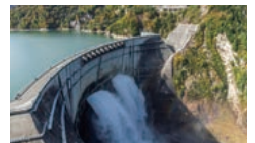
水力（揚水）発電所
