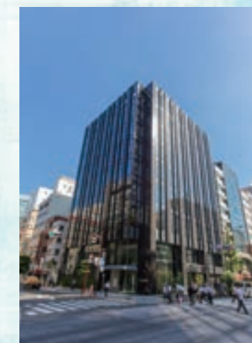
新本社ビル竣工
