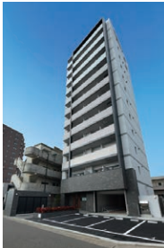
都市型分譲マンション パルティール八田
