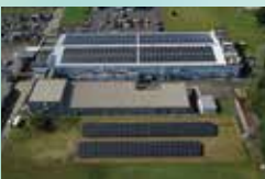
地域内に設置された太陽光発電システム
