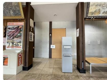
■ 設置した製水機「AirQua」
