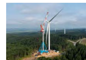
建設工事におけるSMTC施工の全景
