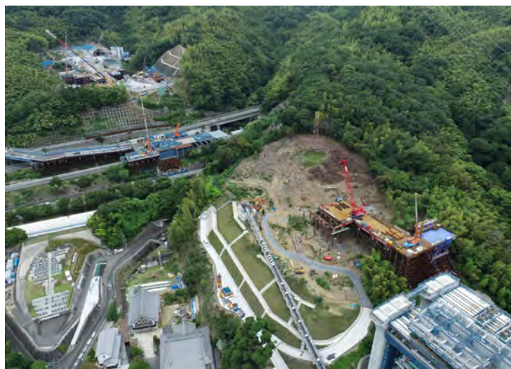
梶原トンネル工事 日本の新たな大動脈、新名神を建設中(大阪府高槻市)
