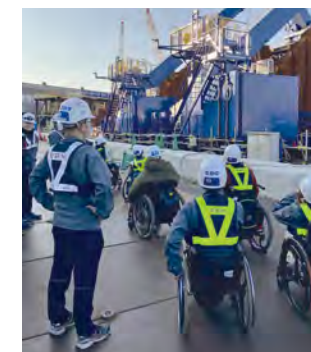
新名神枚方トンネル建設所の現場見学会
