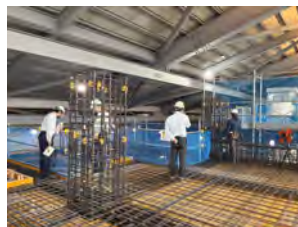
モックアップを利用した配筋検査研修
