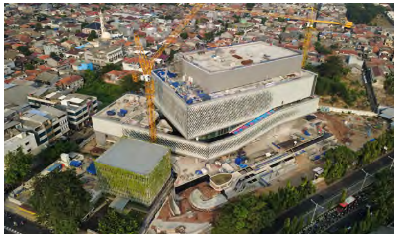
外装は概ね完成し、仕上工事が進行中
