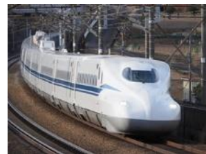
鉄道架線・電線など インフラ設備
