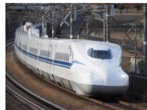
鉄道架線・電線など インフラ設備
