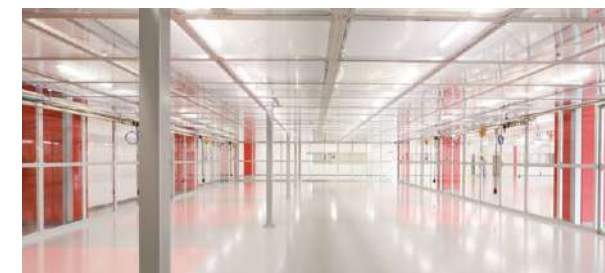
スーパークリーンルーム
