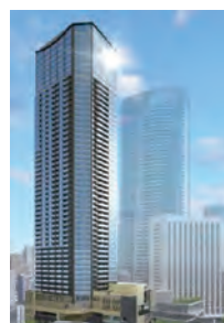
西麻布三丁目北東地区第一種市街地再開発事業 A街区
