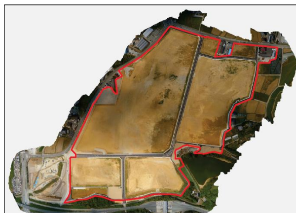
本プロジェクト全体航空写真（造成工事完了）
