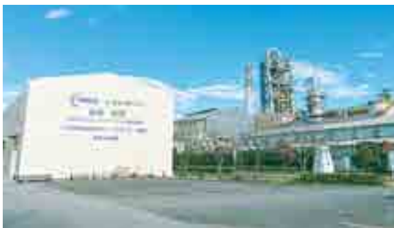
栃木工場人工石灰石パイロットスケール製造試験設備
