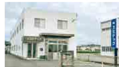
(上) 静電チャックの新製造棟を竣工 (下) ㈱スミテック第2工場を竣工
