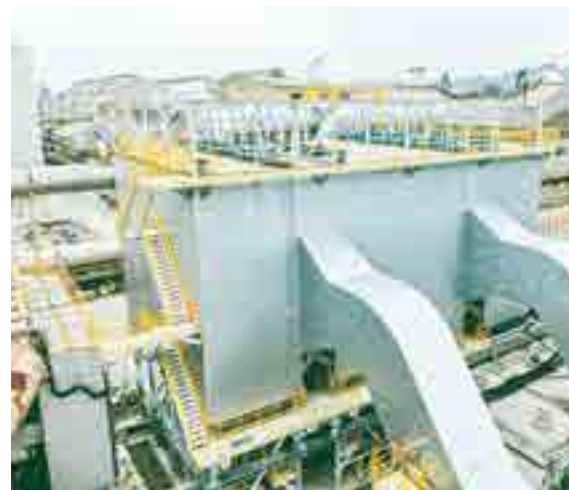
赤穂工場バグフィルター集塵機
