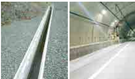
人工石灰石を用いたCO 2 固定コンクリートのプレキャスト製品の実証施工箇所(左:成瀬ダム原石山採取工事(落蓋U形側溝) 右:荒島第二トンネル工事(縦壁付矩形水路))
