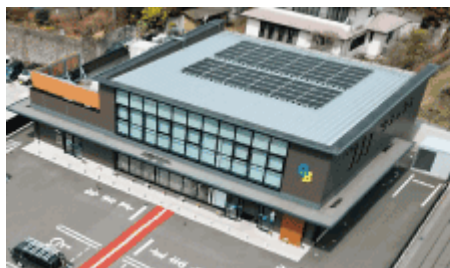
太陽光発電設備を設置した中之条支店
